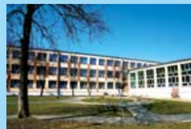
Termomodernizacja ZPO Nr 2
