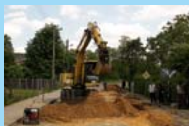
Wymiana kanalizacji w ul. Kolejowej
