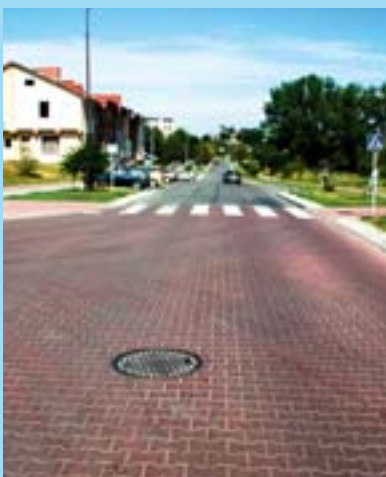
W ramach remontu ul. Mieciewicza, wykonana została nie tylko nowa nawierzchnia, ale również chodniki i ścieżka rowerowa. Zadbano także o przechodniów, którzy mogą odpocząć na eleganckich ławeczkach. Obecnie ulica ta należy do najbardziej reprezentacyjnych ulic w Staszowie. Remont ul. Mickiewicza w Staszowie, kosztował 1,87 mln zł.
