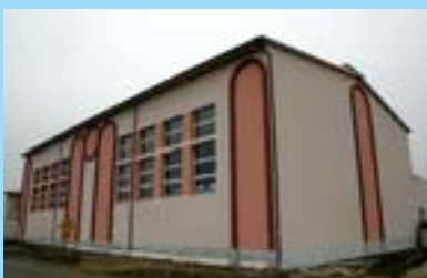
Czajków - budynek hali sportowej przy gimnazjum
