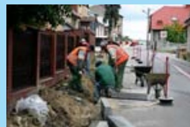
Budowa chodnika, ul. Wschodnia
