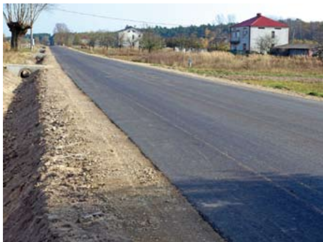
Przebudowa drogi gminnej Wiązownica Kolonia – Browary – II etap. Parametry: dł. 1300 [m], szer. 6 [m] Wartość zadania: 488 596,58 zł Wartość nadzoru inwestorskiego: 6 222,00 zł
