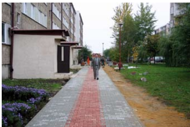
Przebudowa chodników przy ul. Mickiewicza 46, ul. Kollałtaja 4, ul. Kilińskiego 1 i 3 oraz ul. M. Skłodowskiej przy bloku nr 1 Parametry łącznie: 1 292,00 [m 2 ] Wartość zadania łącznie: 137 311,00 zł
