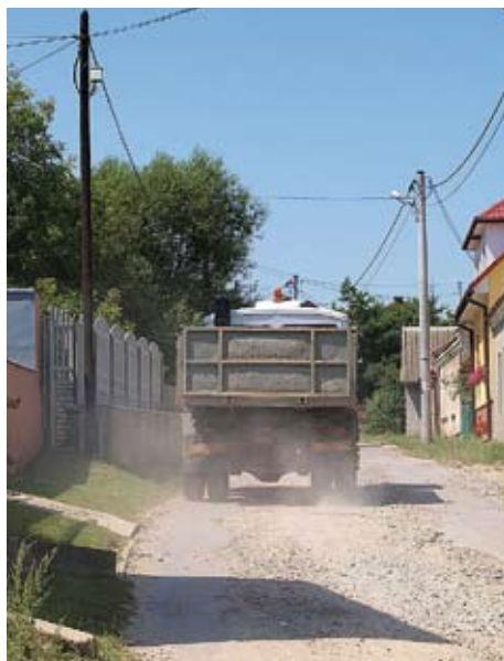
Zakończono realizację zadania pn. „Budowa sieci wodociągowej wraz z przyłączami domowymi w miejscowościach Staszów - Kurozweki II etap.” Wartość: 616632,30 zł Wartość nadzoru: 5000,00 zł
