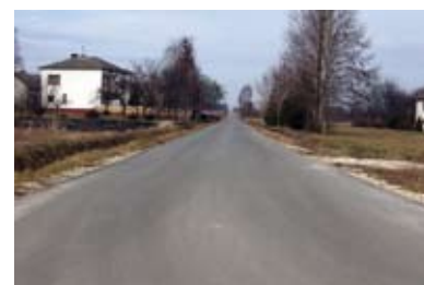
Przebudowa drogi gminnej Sielec - Ogłędów
