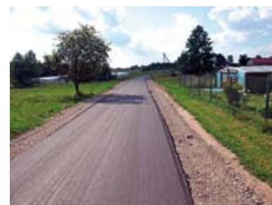
Przebudowa drogi gminnej w Krzczonowicach
