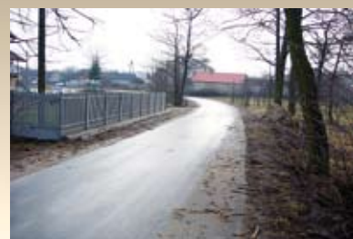
Przebudowa drogi gminnej w Woli Wiśniowej
