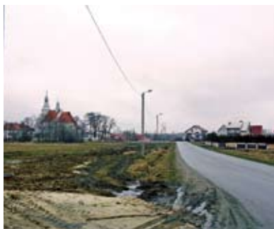
Przebudowa oświetlenia ulicznego -budowa ulicznego przy ul. Południowej w Koniełotach
