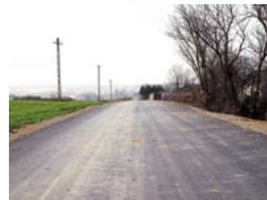
Przebudowa drogi gminnej w Jasieniu
