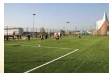
Budowa kompleksu sportowego wraz z infrastrukturą techniczną w ramach programu „Moje boisko-Orlik 2010” w Staszowie
