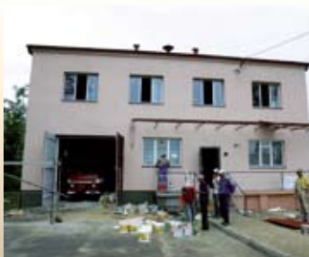
Remont strażnicy w Niemścicach
