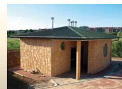
Budowa szaletu w Staszowie
