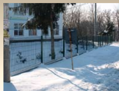
Remont ogrodzenia w ZPO w Wią-zownicy Dużej
