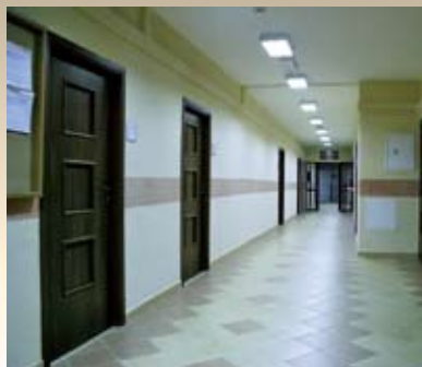
Remont budynku Urzędu Miasta i Gminy w Staszowie
