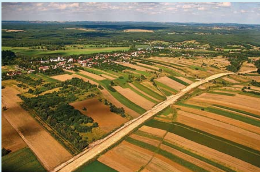
Obwodnica Kurozwałk, wkrótce wyprowadzi ciężki ruch samochodowy poza centrum miejscowości. Zaprojektowanie i rozpoczęcie inwestycji było możliwe, dzięki zgodnej współpracy samorządów wszystkich szczebli.
