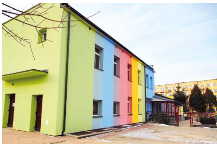
Termomodernizacja przedszkola Nr 8 w Staszowie
