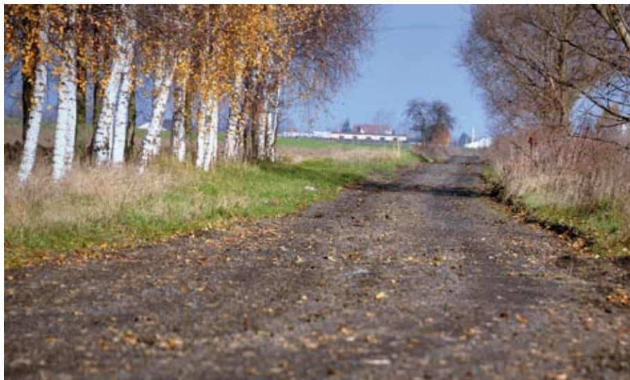
Bieżący remont drogi szutrowej w Stefanówku
