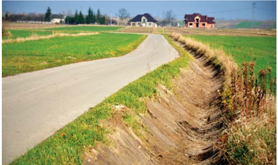
Konserwacja rowów w Lenartowicach
