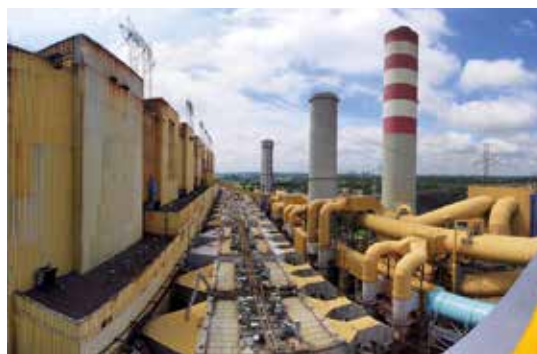
Widok z dachu „Zielonego Bloku”
