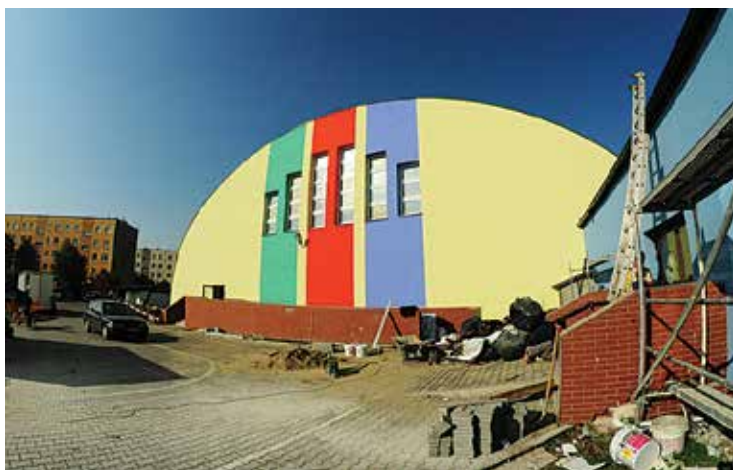
Termomodernizacja Hali OSiR
