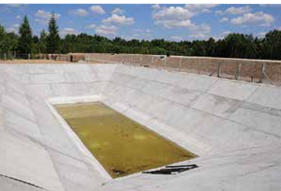
Zbiornik przeciwpożarowy przy kwaterze składowania odpadów
