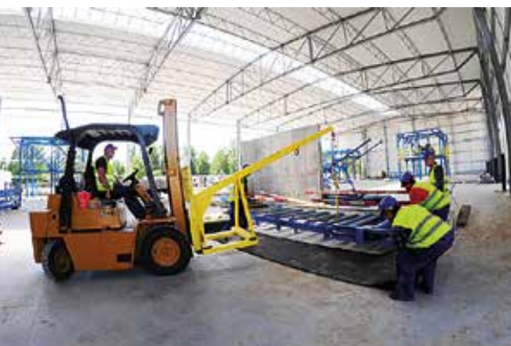
Montaż linii sortowniczej
