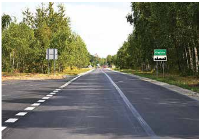
Fragment drogi powiatowej w Grzybowie
