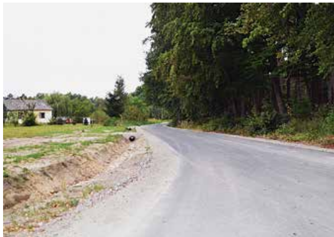
Droga powiatowa w Poddębowcu
