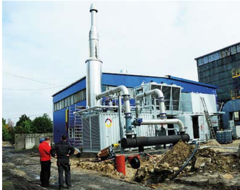
ZEC w Staszowie w trakcie modernizacji
