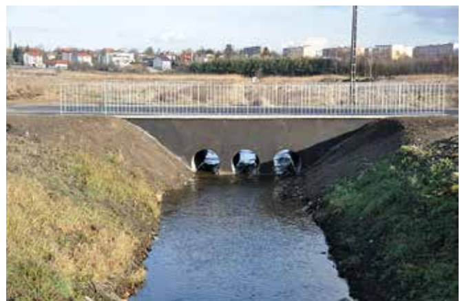
„Wymiana przepustu drogowego w ciągu ul. Długiej w Staszowie”. Wartość 99 833,54 zł
