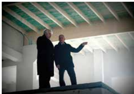
Burmistrz i Starosta na budowie Powiatowego Centrum Sportowego
