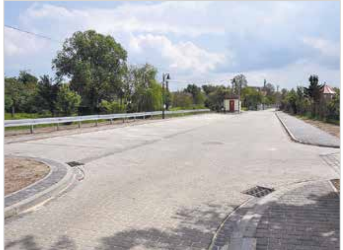
Przebudowa ulicy Łazienkowskiej w Staszowie Wartość zadania: 671 200,00 zł
