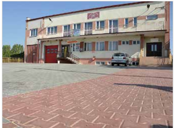
Utwardzenie placu przy Domu Strażaka w Woli Osowej. Wartość 60 528,30 zł
