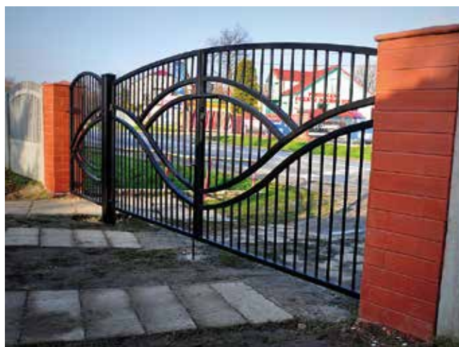
Ogrodzenie świetlicy w Sielcu
