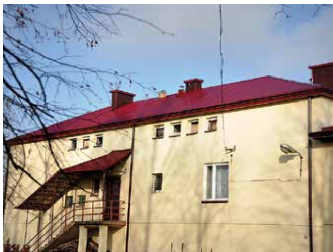
Nowe pokrycie dachowe na budynku Ochotniczej Straży Pożarnej w Koniemłotach
