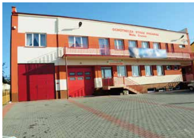
Termomodernizacja OSP w Woli Osowej
