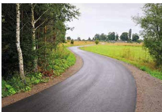
Staszów, ul. Na Kępie I etap
