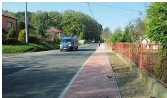
Budowa chodnika w Wiśniowej
