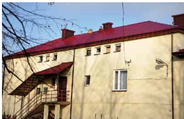
Nowe pokrycie dachowe na budynku Ochotniczej Straży Pożarnej w Koniemłotach
