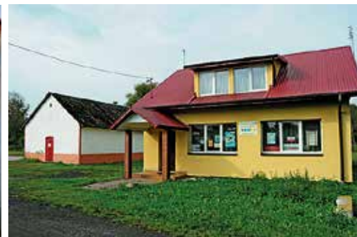
Świetlica w Grzybowie, przed modernizacją
