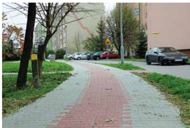
Remont chodnika przy ulicy Kilińskiego
