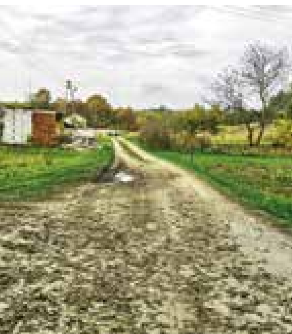
ul. Adamówka, przed rozpoczęciem prac
