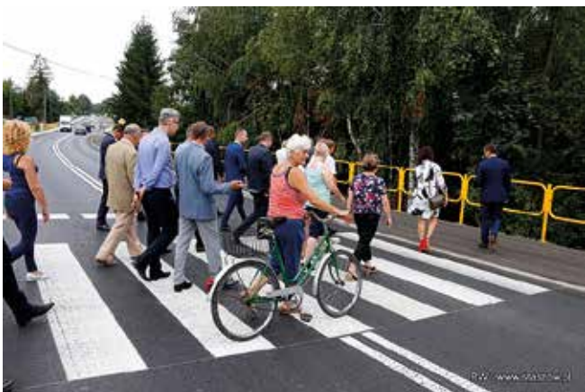
Przebudowany fragmentu drogi Staszów - Stopnica, w Sielcu
