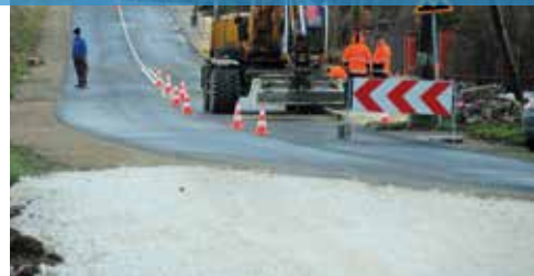
Przebudowa dróg w Kurozwałkach
