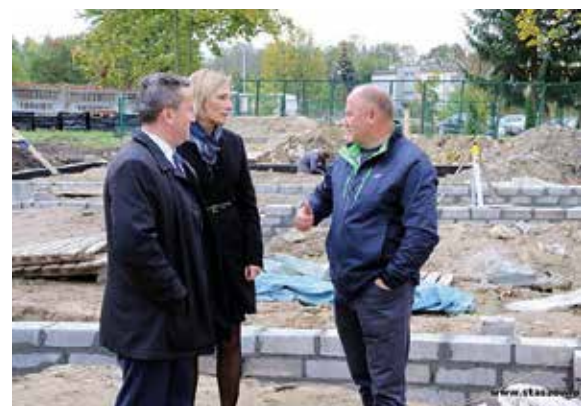
Rozbudowa przedszkola nr 3 w Staszowie
