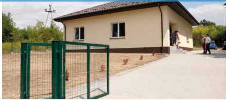
Mieszkanie socjalne w Wiązownicy-Kolonii
