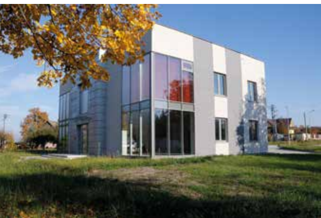
Budowa siedziby Lokalnej Grupy Działania „Białe Ługi”.
