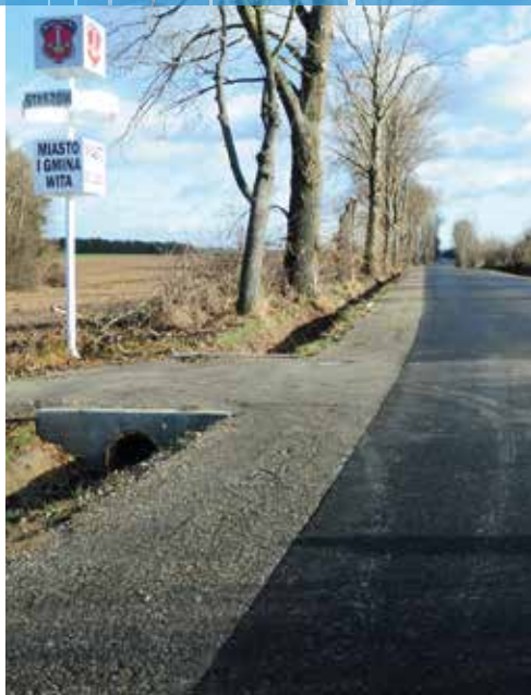
Przebudowa dróg w Kurozwałkach
