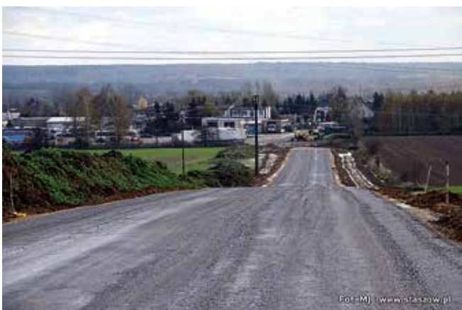
Budowa obwodnicy południowej
