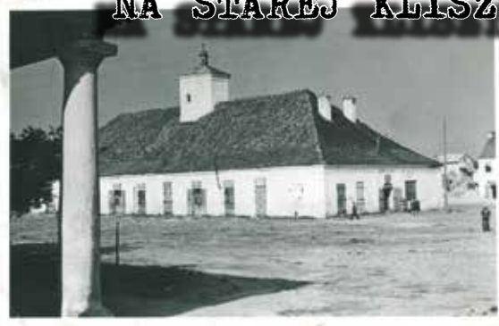
Staszowski ratusz w latach 50. Zdjęcie wykonane od strony ul. Kościelnej i nieistniejącego już domu z podcieniami. Fot. T. Przepkowski.
