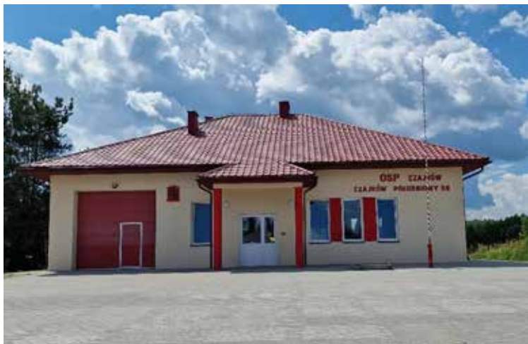
„Budowa budynku remizy Ochotniczej Straży Pożarnej w Czajkowie Południowym” Wartość: 690 000,00 zł .
