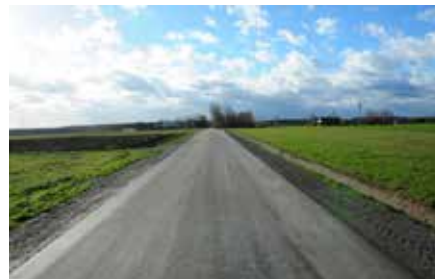
Przebudowa drogi gminnej nr 003722T w Krzczonowicach (782 mb). Wartość zadania: 161 737,15 zł , dofinansowanie 109 038,00 zł .
