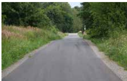
Przebudowa drogi gminnej Wólka Żabna – Przysiółek Smugi. Wartość zadania 429 266,46 zł ; dofinansowanie 273 142,00 zł
