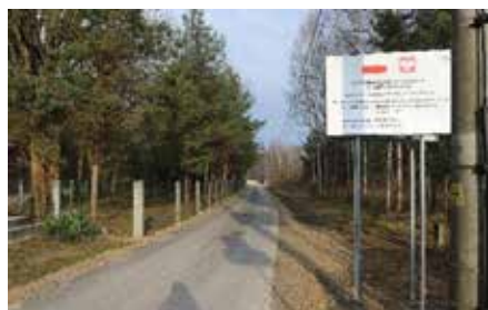
Przebudowa drogi w Mostkach. Wartość zadania: 230 840,25 zł , dofinansowanie 174 832,00 zł .
