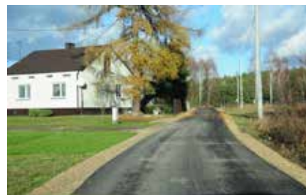
Przebudowa i remont drogi gminnej nr 003798T Dobra - Pocieszka (1 531 mb). Wartość zadania: 245 947,90 zł . Dofinansowanie 242 749, 00 zł .
