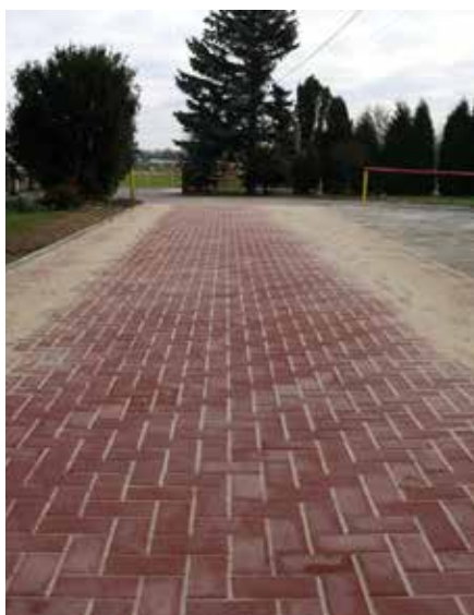
Chodnik przy szkole w Koniemłotach. Wartość inwestycji: 11 500,00 zł .
