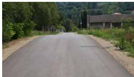
Przebudowa drogi gminnej w Wiązownicy-Kolonii nr 3. Wartość zadania: 174 512,28 zł , dofinansowanie: 134 474,00 zł .
