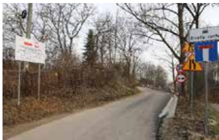
Przebudowa drogi w Ogłędowie. Wartość zadania: 744 538,99 zł , dofinansowanie 559 986,00 zł .
