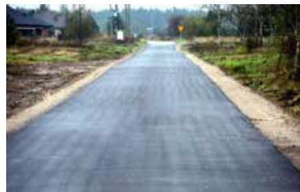
Przebudowany odcinek drogi gminnej Podmaleniec - Dobra
